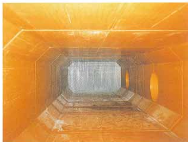
施工完了後の内面
