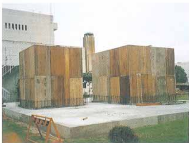
BKUプレート張りつけ前の型枠
