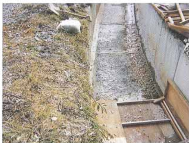
補修前の床面
