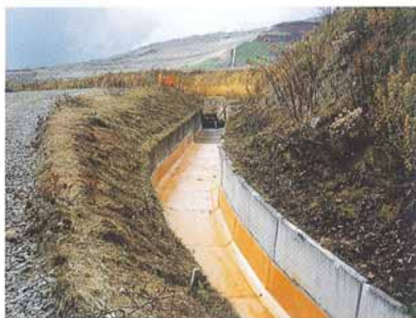
補修完了後の床面
