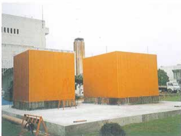
張りつけ完了したBKUプレート
